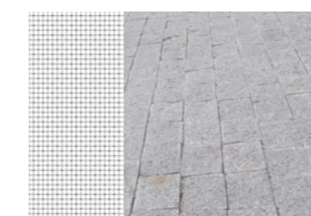
DLAŽBA CHODNÍKOV PO OBVODE NÁMEŠTIA, OKROVÁ ŽULOVÁ MOZAIKA, ŠTIEPANÁ/REZANÁ 4/6, SKLADANÁ DO RIADKOV
